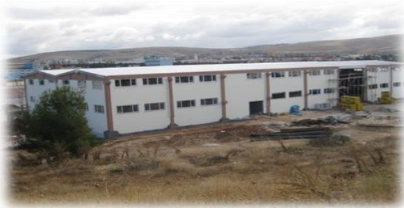
Naci Topçuoğlu Meslek Yüksek Lab. Binası
